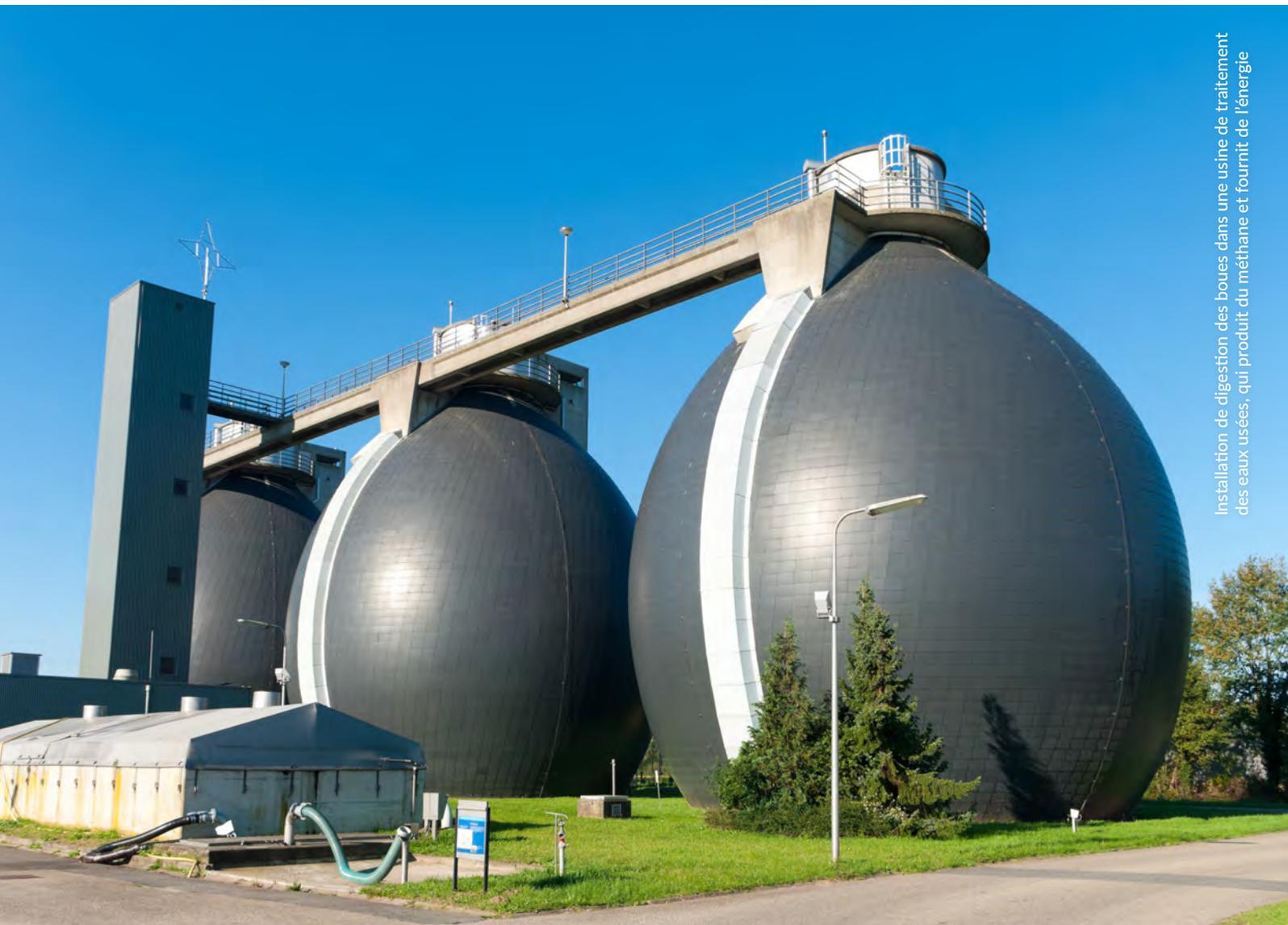
Installation de digestion des boues dans une usine de traitement des eaux usées, qui produit du méthane et fournit de l'énergie
