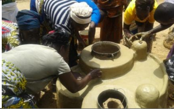
Photo 15 : suite du lissage et réalisation des pose-objet du foyer
