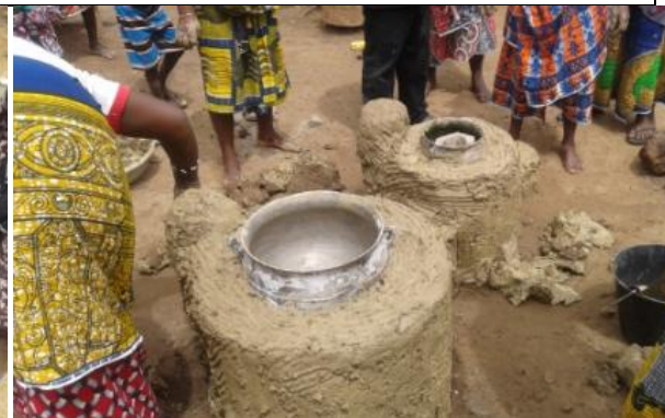
Photo 12 : construction des cheminées des foyers à l'extérieur
