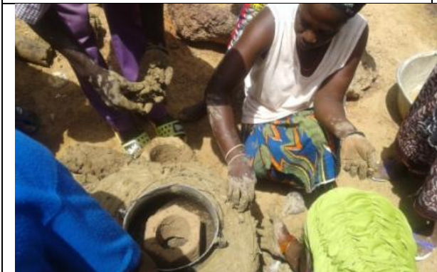
Photo 11 : construction de la chambre de soutien du foyer
