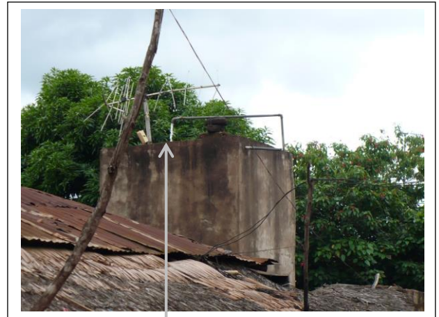
Réservoir en béton ouvert
