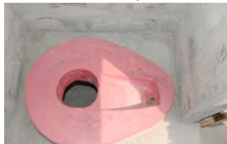
Une cuvette de latrine
