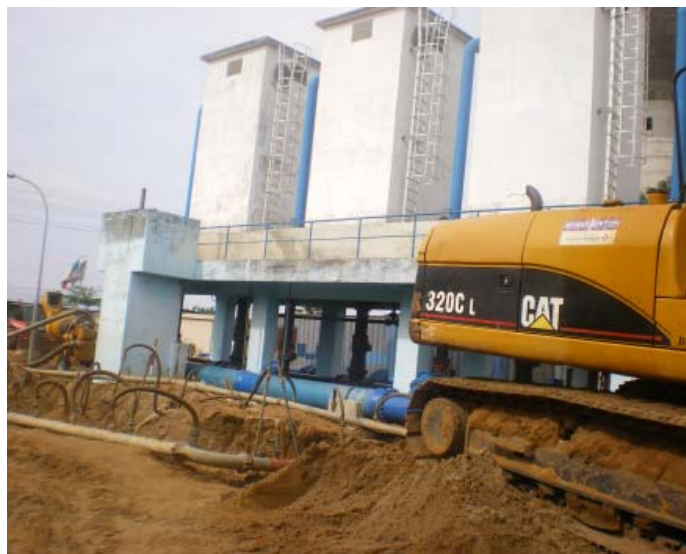
Avec les grands chantiers ouverts...
