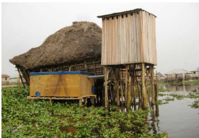
Toilette familiale à fosse septique en polyester
