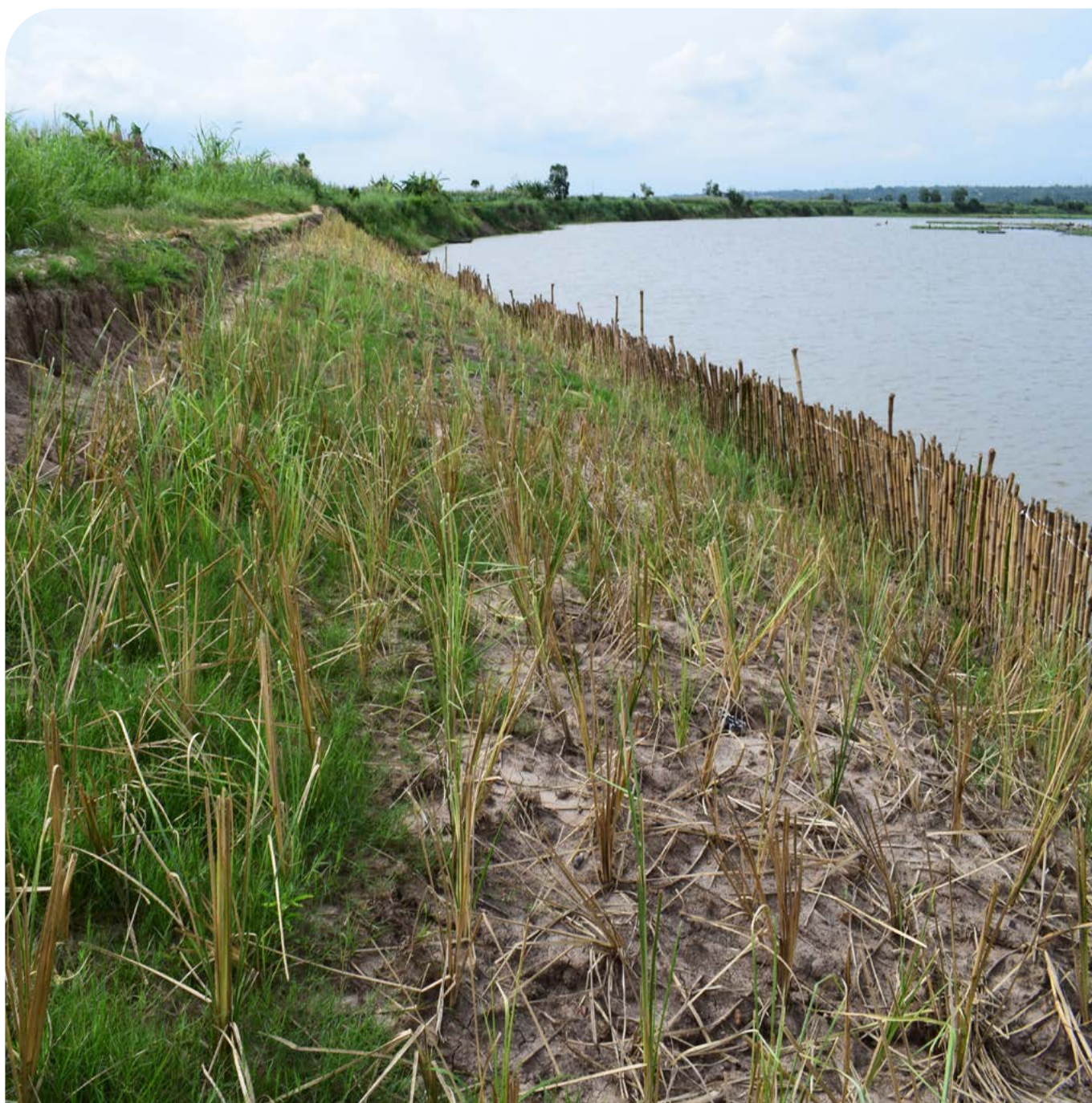
Reboisement et protection de la berge (vétivers et toiles de jute en jacinthe d'eau) à Toghounssa, commune d'Adjohoun par NVW-GIRE (SNV Bénin)
