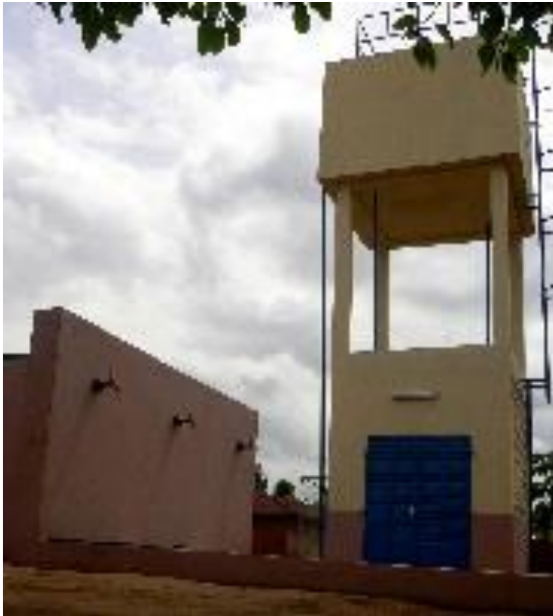
Un poste d'eau autonome (PEA)
