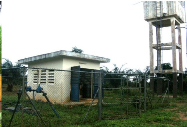
Ensemble forage, abris groupe et le château
