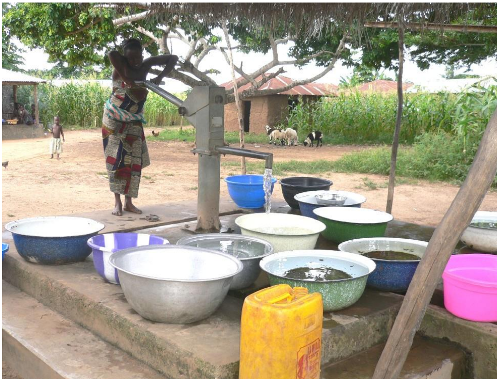
Un Forage équipé d'une pompe manuelle
