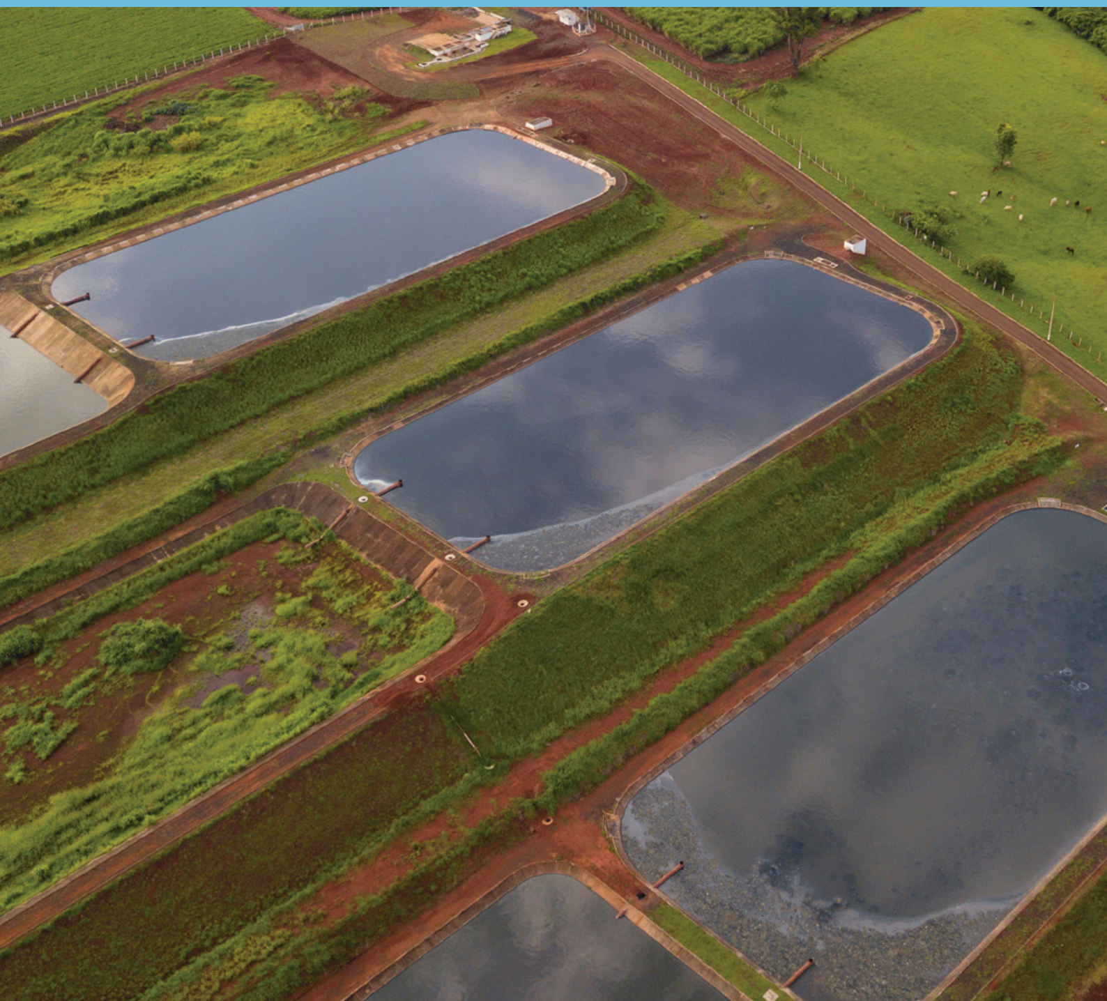
Vue aérienne du traitement des eaux usées.
