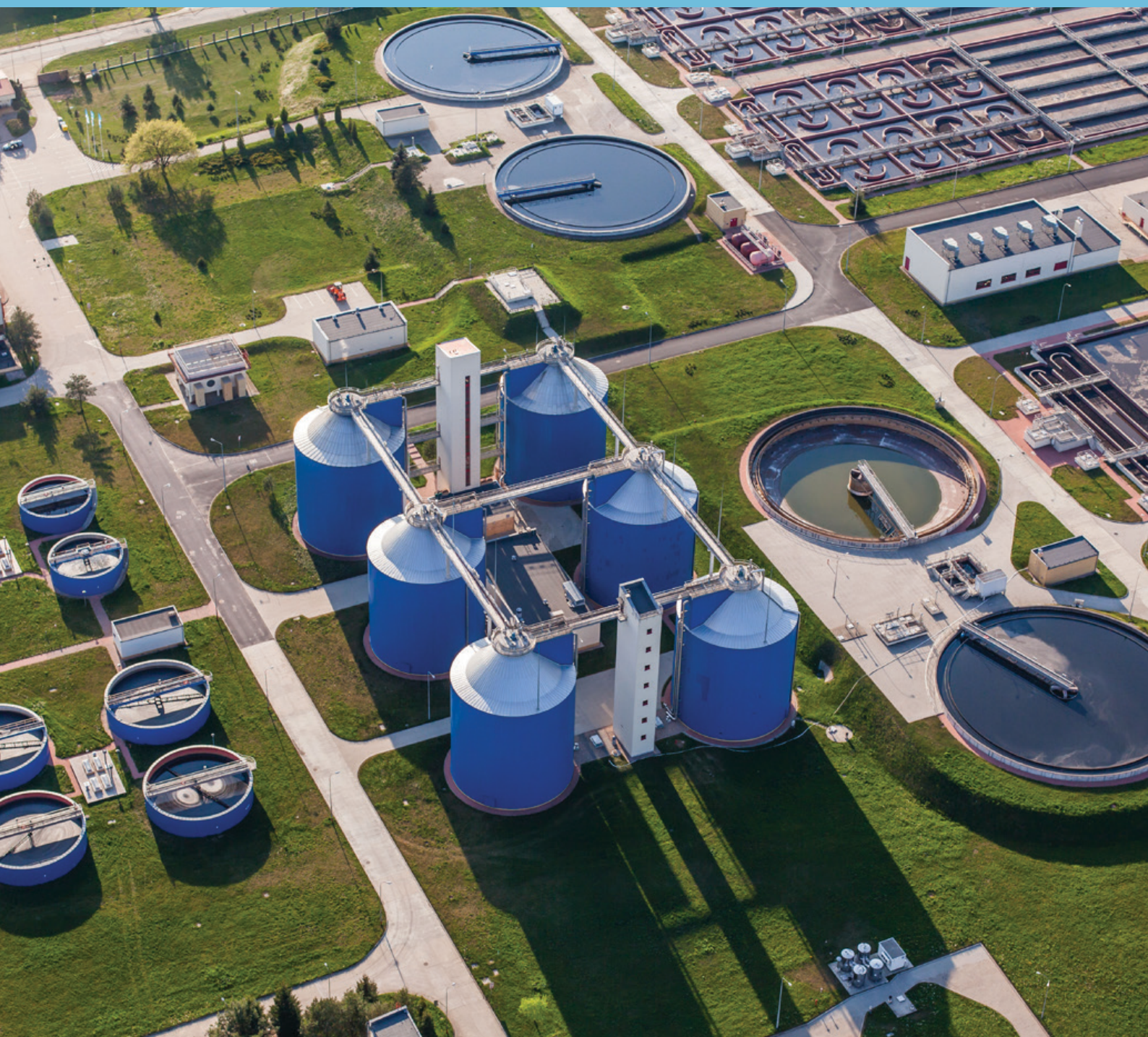
Vue aérienne d'une station de traitement des eaux usées à Wrocław (Pologne).
