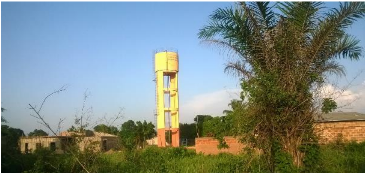
Figure 22 : Château d'eau d'Avogbana construit avec l'appui de CASE
