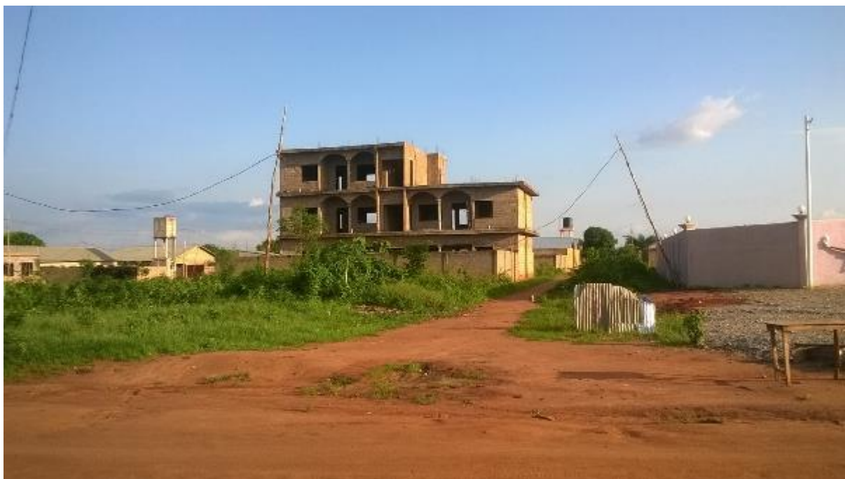
Figure 23 : Nouveau quartier en essor avec de nombreux châteaux d'eau familiaux
